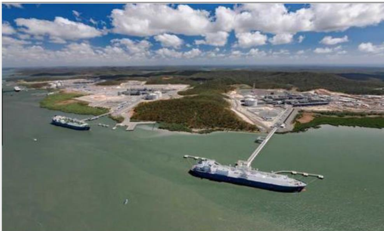
ΣΤΑΘΜΟΣ ΥΓΡΟΠΟΙΗΣΗΣ ΦΥΣΙΚΟΥ ΑΕΡΙΟΥ ΣΤΗΝ ΓΑΥΔΟ ΜΕ ΠΡΟΟΡΙΣΜΟ ΤΗΝ ΑΠΩ ΑΝΑΤΟΛΗ.
